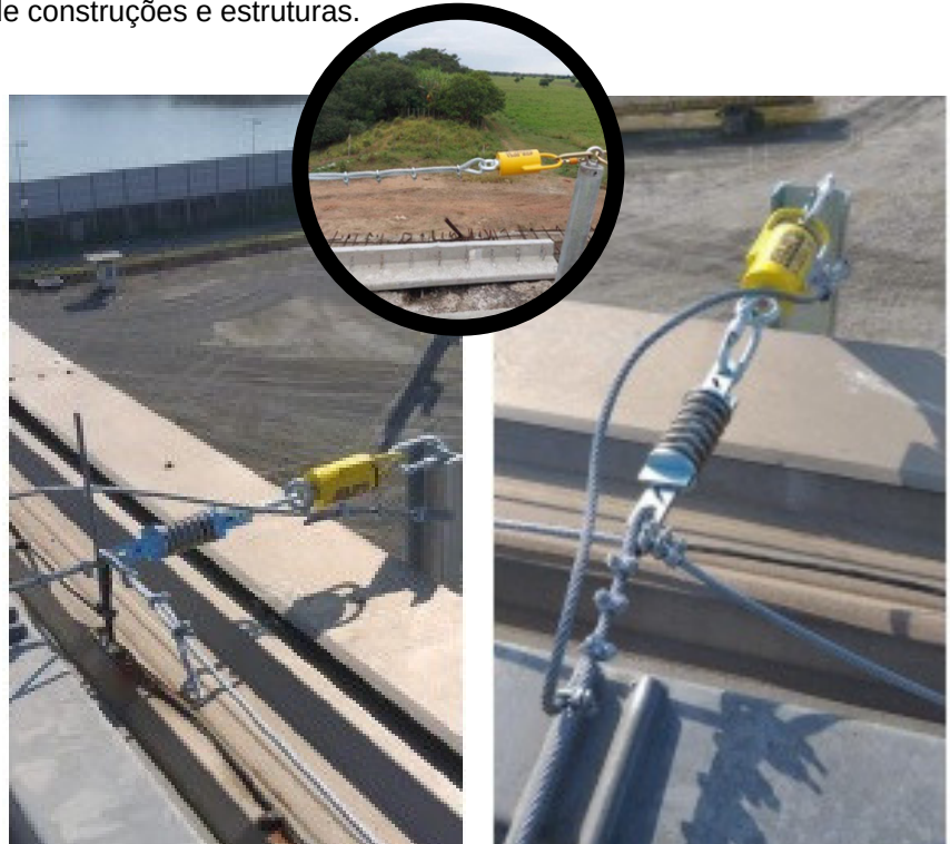
LINHA DE VIDA EM TELHADO COM ABSORVEDOR DE ENERGIA E INDICADOR DE TENSÃO.
